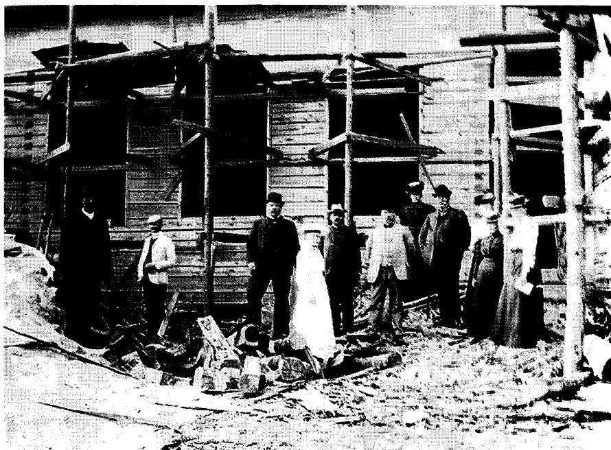
Vaajasalon sairaalan rakennustyömaa. Lääkintöneuvos J.V. Johnsson knalli päässä keskellä kuvaa.
